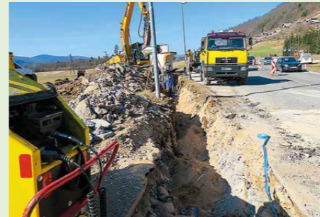
Gradnja primarnega voda Drenje – Dvor
